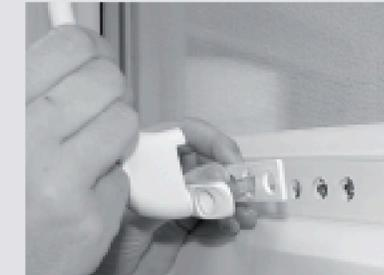
Pour installer cette câle, il faut démonter la poignée de la fenêtre, positionner la câle puis replacer la poignée, comme le montrent les photos ci-contre.
