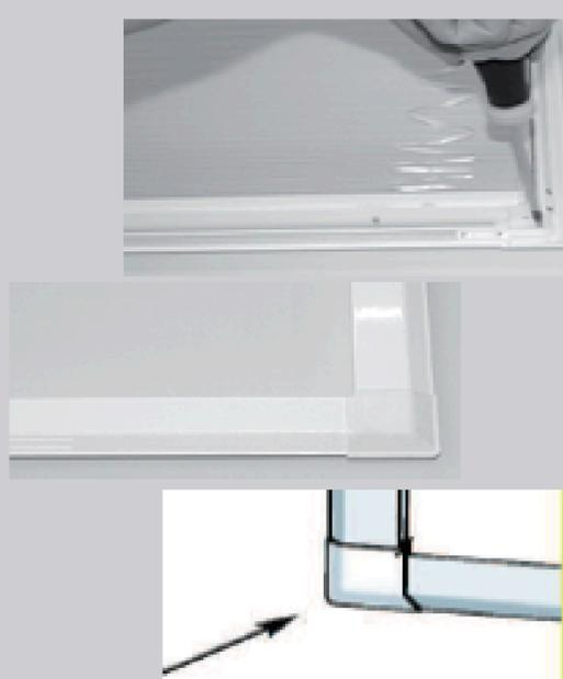
En version enrouleur, le mécanisme est intégré dans le profil supérieur (arrondi), en version vénitien, le store est déjà fixé au profil supérieur. Monter le cadre. Pour ce faire, faire glisser chaque patte du coin PVC dans la rainure du profil et serrer les petites visées. Clipper le cache PVC
